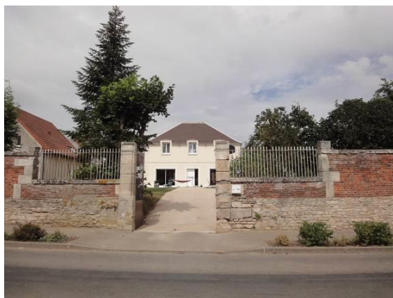
Construction pavillonnaire derrière mur ancien Rue de Montdidier
